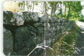
La technique de construction "pierre sèche" fut mise en œuvre dans les constructions néolithiques (6000 et 2500 avant J.-C.). Cette technique d'empilement de pierre permet aujourd'hui encore de soutenir des chemins, routes, voies ferrées, de créer des murs de séparation, des terrasses (gain de surface cultivable). Ces constructions qui dessinent les paysages témoignent de l'art des "paysans bâtisseurs".
